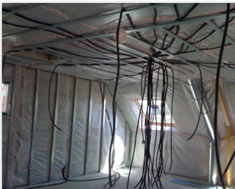
Installation d'un circuit électrique dans une maison
